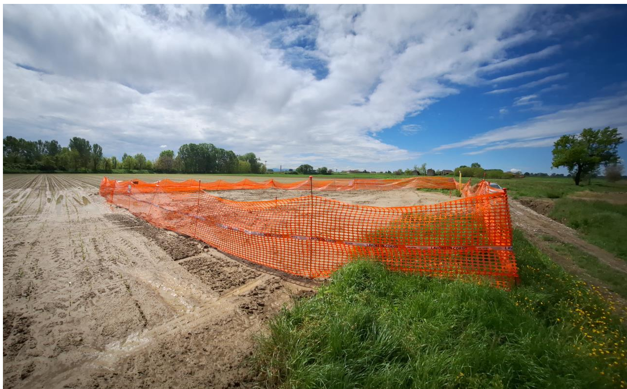
Figura 2: Ripristino e posizionamento recinzione area scavo
