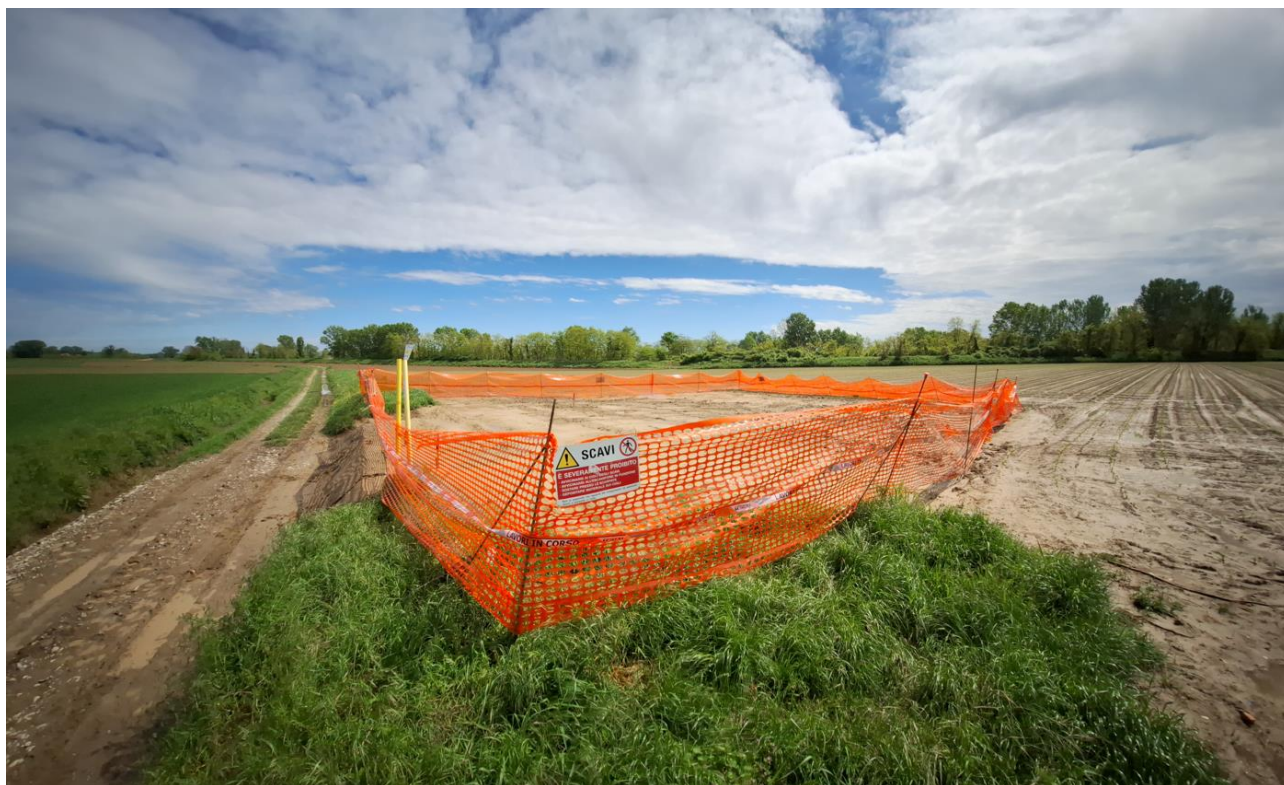
Figura 1: Ripristino e posizionamento recinzione area scavo
