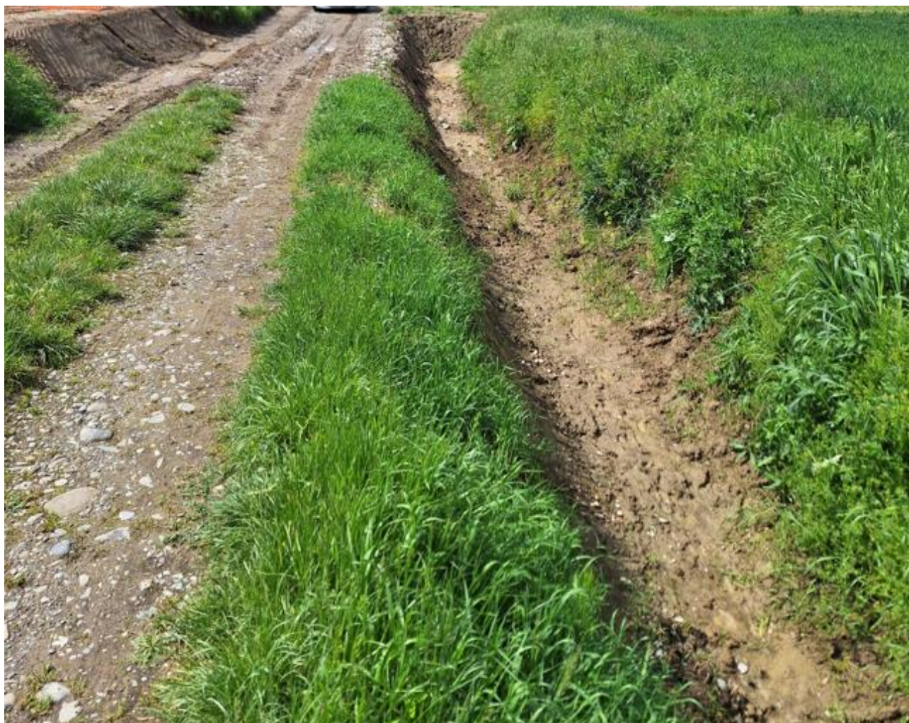
Figura 4: Ripristino strada e fosso irriguo
